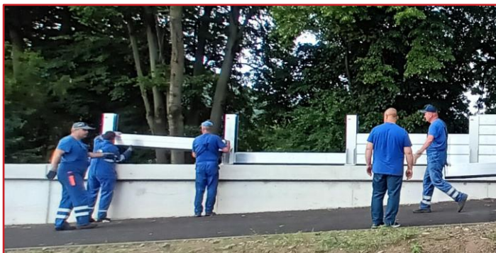
Ugradnja linearne zaštite
