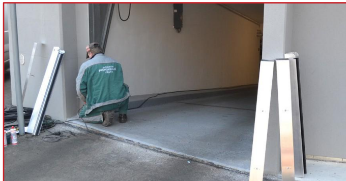
Ugradnja bočnih vođica
